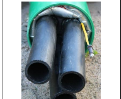
Beispiel: mit Abdichtstern und UA/V abgedichtetes Mehrfach- Kabelschutzrohr
