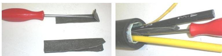
Abdichtelement (Nr. 1) nach Montageanweisung vorbereiten, um das Kabel legen und in das KKR einschieben
