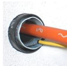
Abdichtelement (Nr. 1) nach Montageanweisung vorbereiten, um das Kabel legen und in das KKR einschieben.
