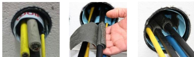
Abdichtelement (Nr. 1) nach Montageanweisung vorbereiten, um das Kabel legen und in das KKR einschieben
